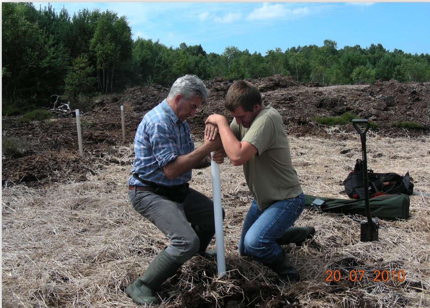
Montaż piezometrów, w których umieszcza się divery
